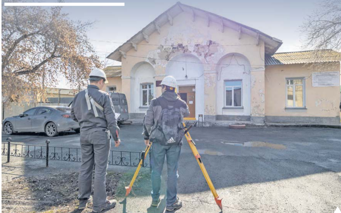
Бригада геодезистов исследует стены здания библиотеки | Фото Кирилла Васильева
