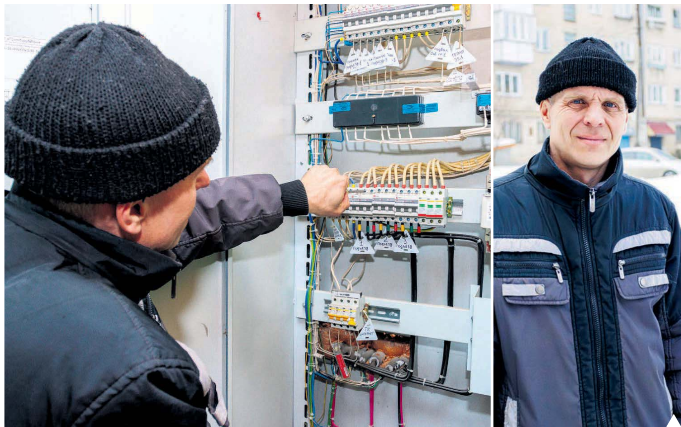
Электромонтер Сергей Пискунов на своём участке | Фоторепортаж Кирилла Васильева
