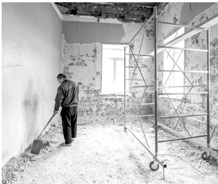
В здании библиотеки семейного чтения начинаются внутренние работы
