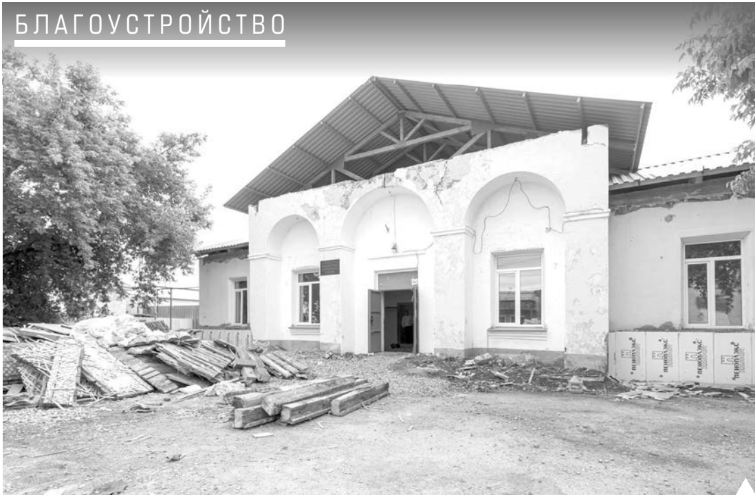
Подрядчики заменили балки и «зашили» кровлю профнастилом | Фоторепортаж Кирилла Васильева
