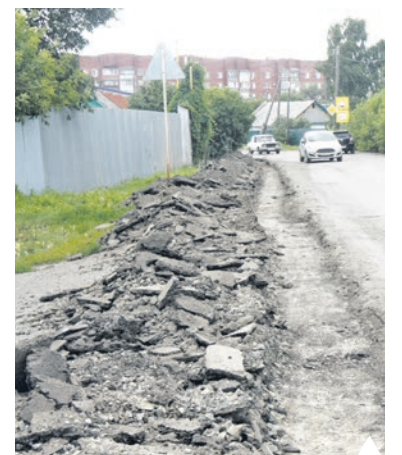
Начались подготовительные работы | Фото автора
