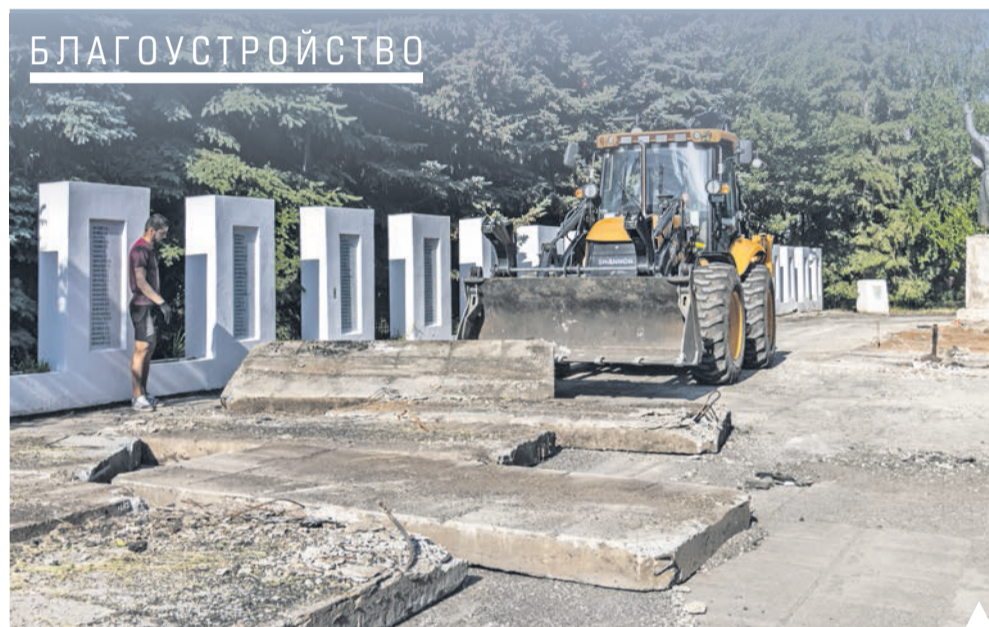
Подрядчики демонтируют бетонные плиты на Аллее Памяти | Фото Кирилла Васильева
