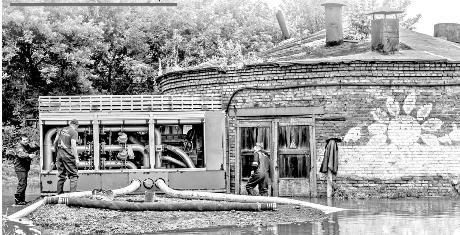
Из спецчасти МЧС в Коркино прибыла мощная установка для откачки воды с КНС-2 «Новой» на улице Терешковой | Фото Кирилла Васильева
