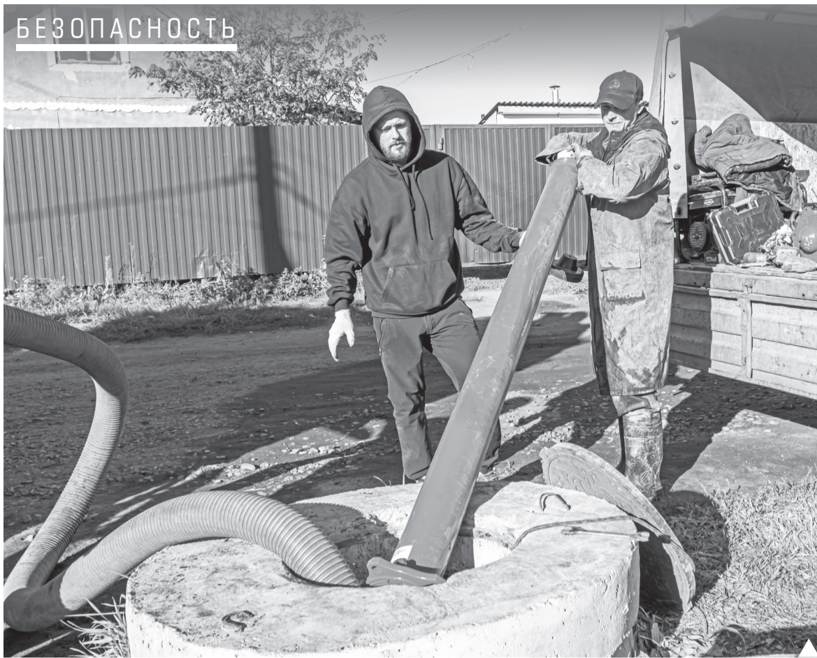
Сотрудники ПУПР Антон Стуров (слева) и Евгений Гааб устанавливают новый гидрант | Фото Кирилла Васильева
