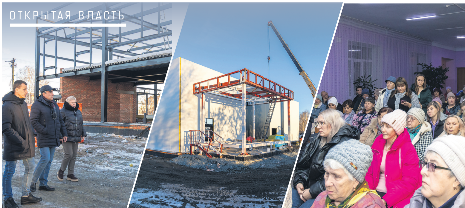
Александр Орёл посмотрел, как идёт строительство ДК на Розе и ответил на вопросы жителей | Фоторепортаж Кирилла Васильева
