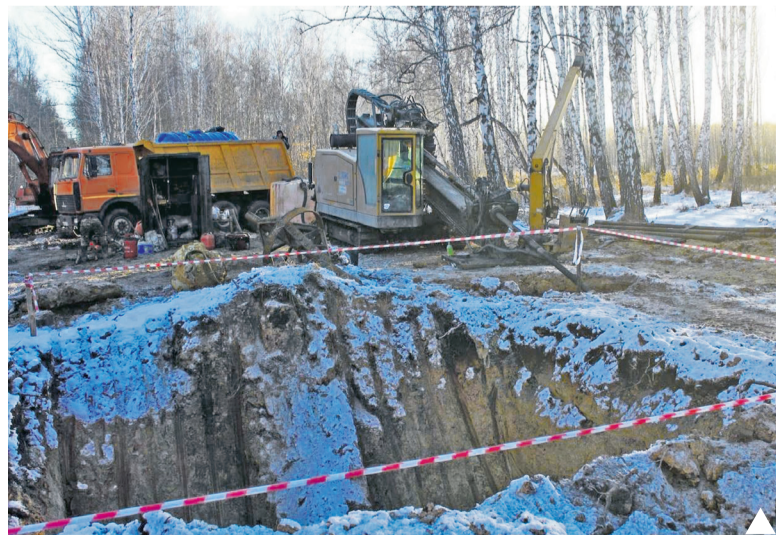
Идёт разработка траншеи
