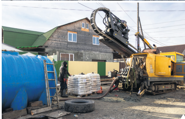
Бурение скважины для нового коллектора на улице Островского | Фоторепортаж Кирилла Васильева
