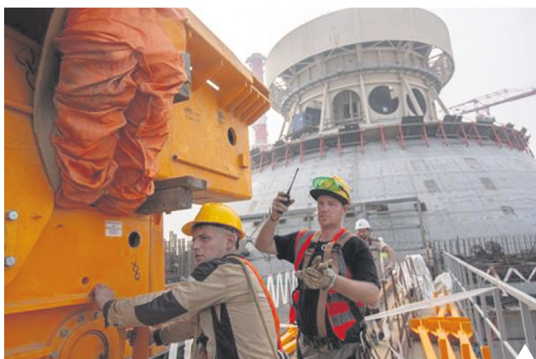
Специалисты монтируют мостовой кран для атомного реактора в Бангладеше
