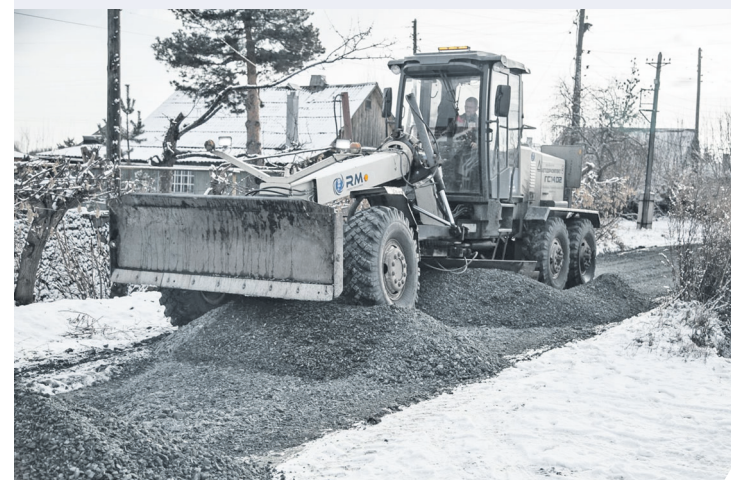
Отсыпка дорог на Старом строительстве | Фото окружной пресс-службы
