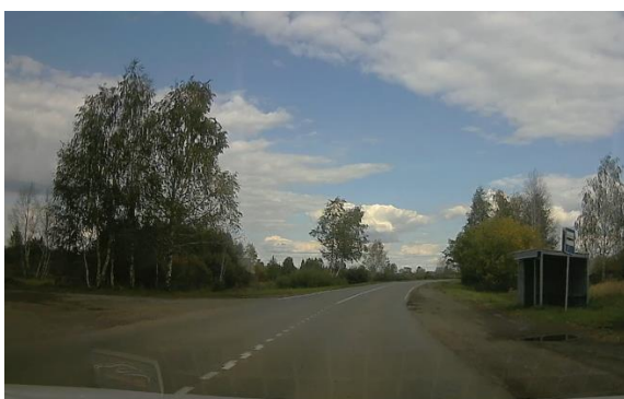
Остановочный пункт «Сад Шахтер» (75К - 581 (2 км до поворота на Калалево))
