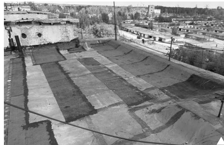
Кровля после частичного ремонта
