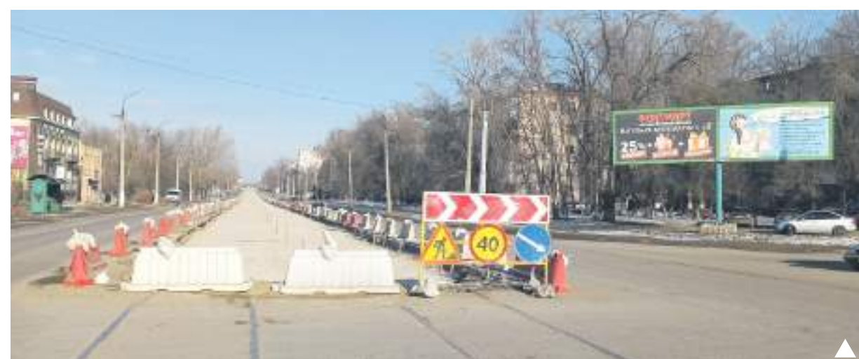
Дороги расширяются за счёт демонтажа трамвайных линий
