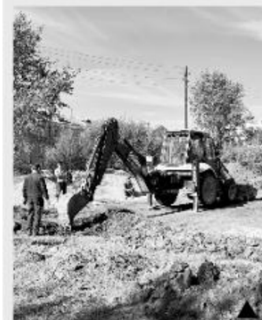
Строительство новой хоккейной коробки во дворе дома №22 на улице 9 Января | Фото окружной пресс-службы
